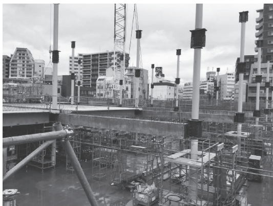
写真 - 11 PC 梁架設状況
