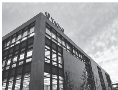
写真 - 1 建物外観
