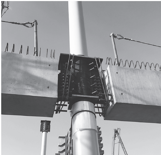
写真 - 3 PC 梁端部
