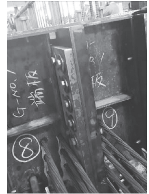
写真 - 10 鋼製型枠状況
