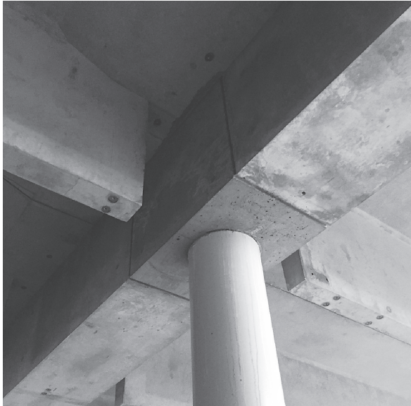
写真 - 6 PC 梁と鉄骨柱の仕口
