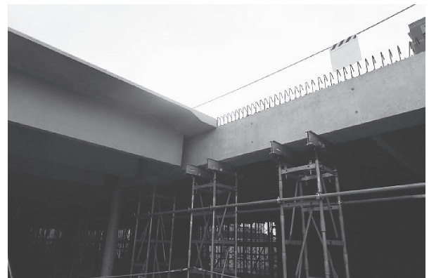
写真 - 12 ST 版架設状況
