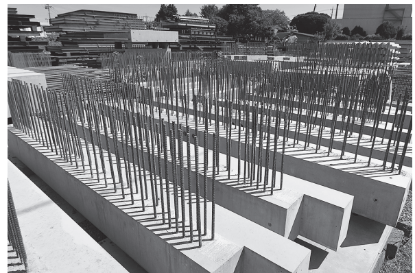
写真 - 3 環境テラス梁製作状況
