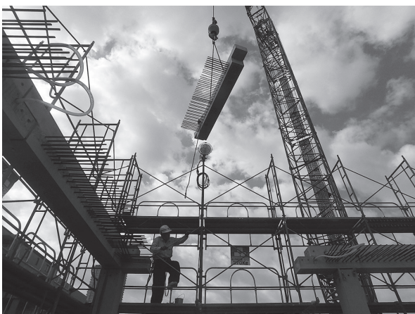
写真 - 6 ピン接合 PCa 梁建方状況
