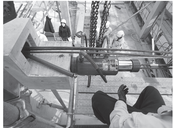
写真 - 7 緊張作業
