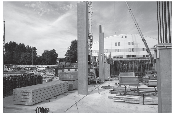
写真 - 8 内部柱建方
