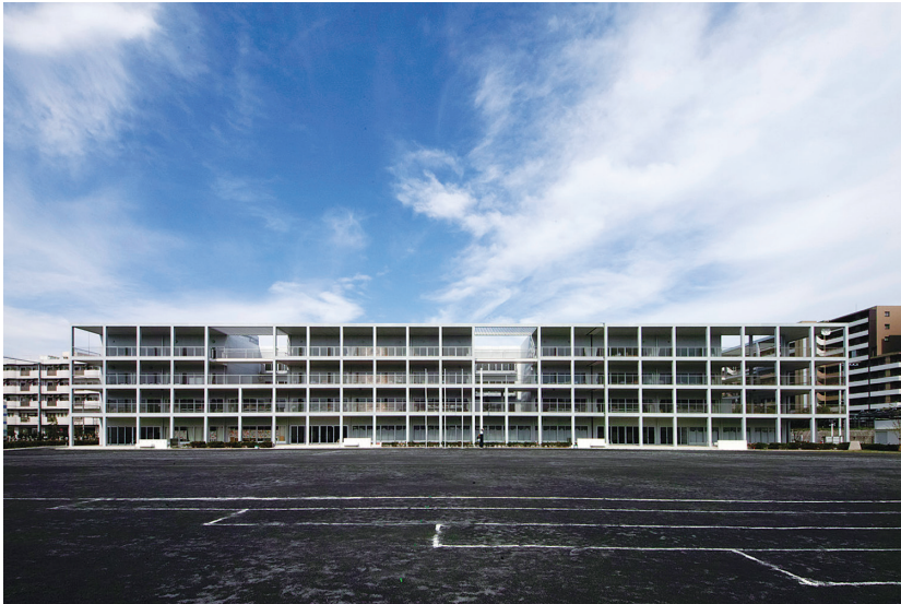
写真 - 1* 建物全景
