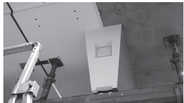
写真-7 モックアップによる塗装仕上げの検証
