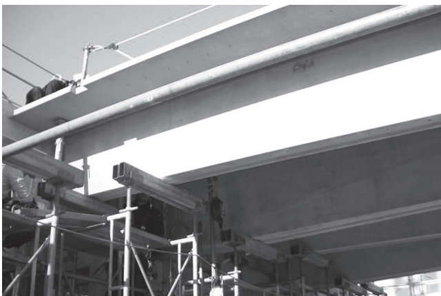
写真 - 9 PCa 部材の架設完了状況
