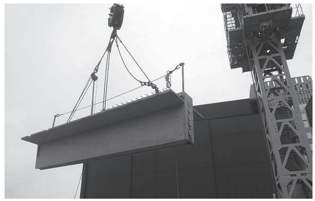
写真 - 8 PCa 部材搬入、吊上げおよび架設状況
