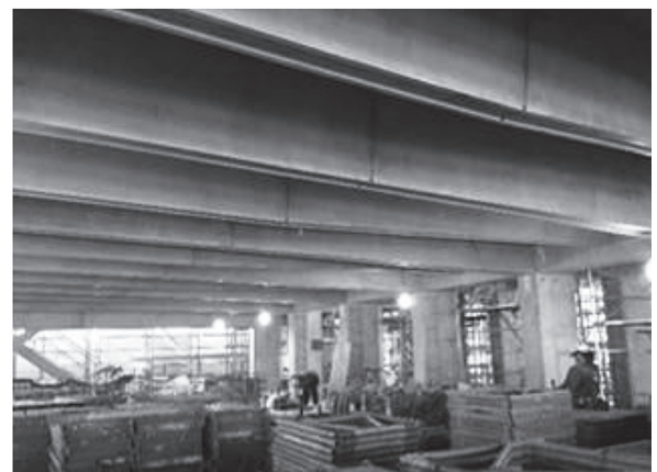
写真 - 9 PCa 部材の架設完了状況
