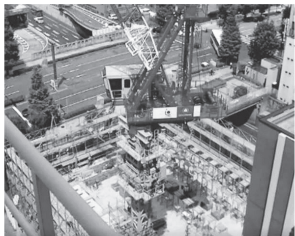
写真 - 4 狭小敷地における架設状況
