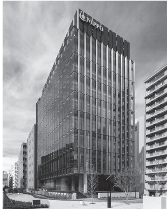
写真-3 北東側ダブルスキン外観
