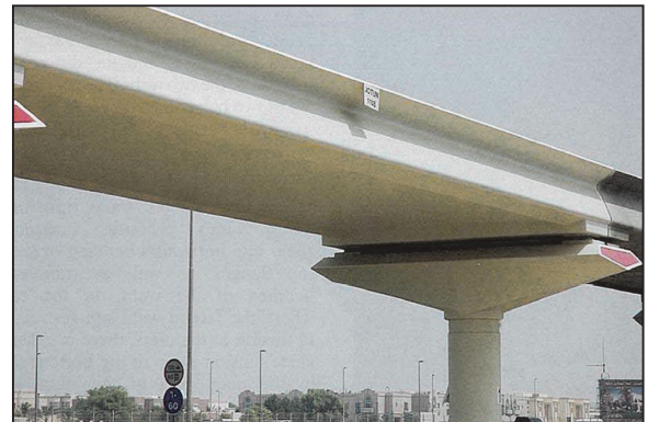
写真 - 5 ドバイ地下鉄、標準桁
