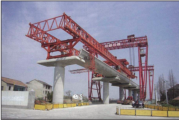
写真 - 2 架設桁架設状況
