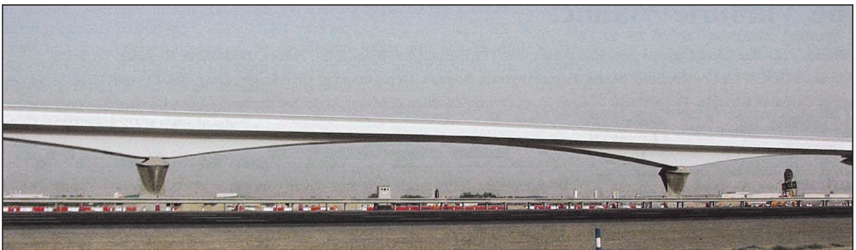
写真 - 6 ドバイ地下鉄、長大支間
