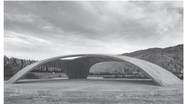
写真 - 6 マンタの全景
