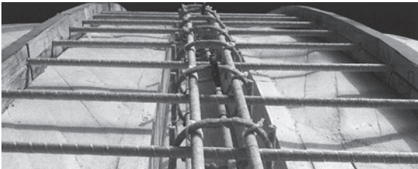
写真 - 3 施工中の大聖堂の屋根
