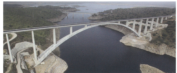
写真 - 12 鉄道橋の全景
