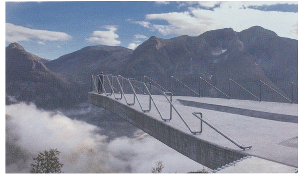
写真 - 11 空中に大きく張り出した先端
