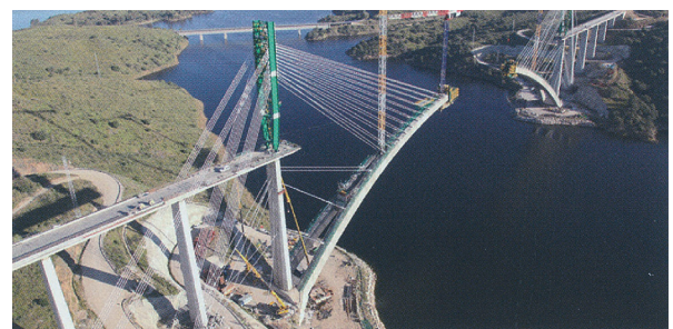
写真 - 13 アーチの片持ち架設状況
