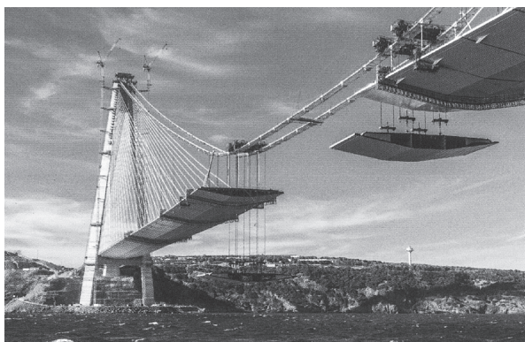
写真 - 17 セグメントの架設状況
