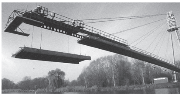
写真 - 15 セグメントの架設状況
