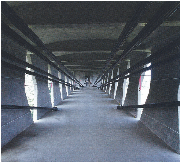
写真 - 9 明るい桁内空間
