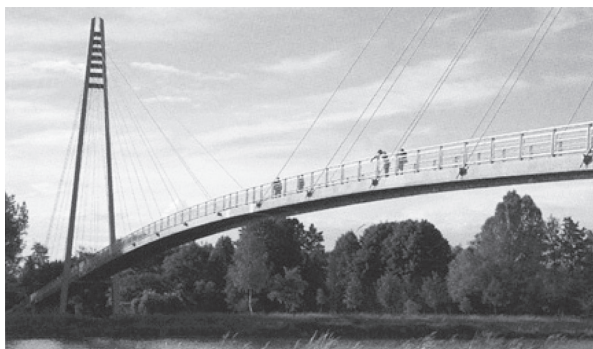
写真 - 14 歩行者専用橋の全景
