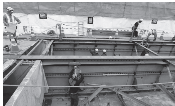
写真 - 5 主桁補強状況
