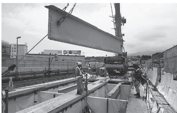
写真 - 4 中間床版および縦桁撤去状況
