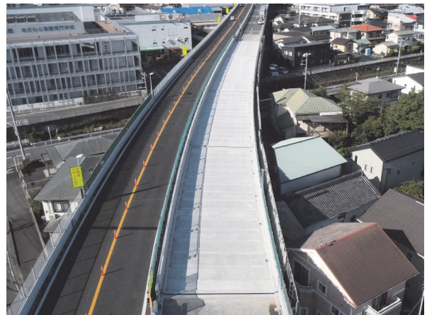
写真 - 10 床版取替え完了後全景
