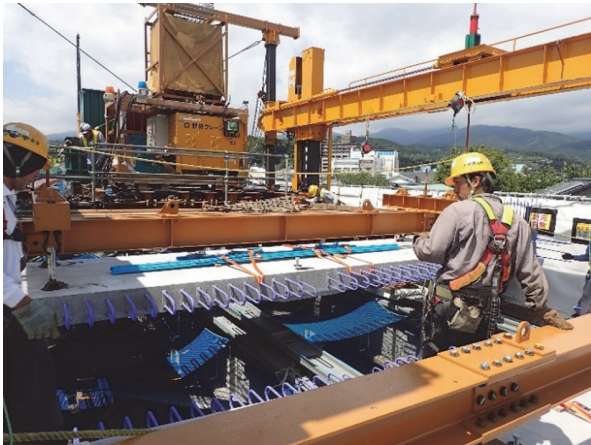
写真 - 9 PCaPC 床版架設状況
