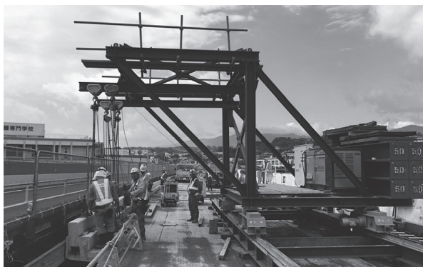
写真 - 3 張出し床版撤去状況
