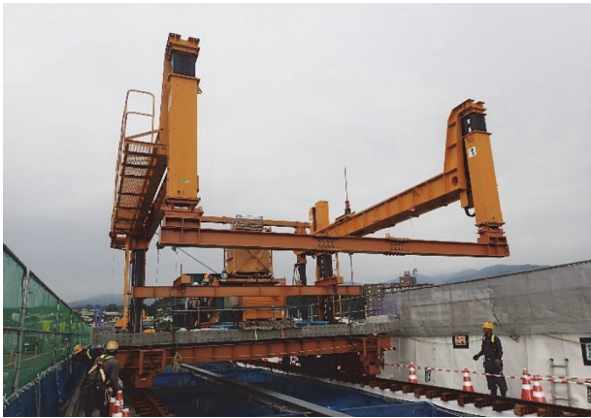
写真 - 8 床版架設機走行状況
