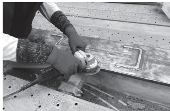
写真 - 6 上フランジ処理状況
