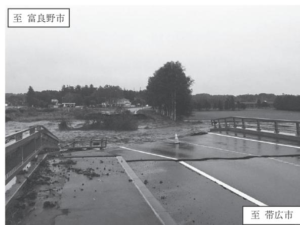
写真 - 2 旧橋の被災状況その 2
