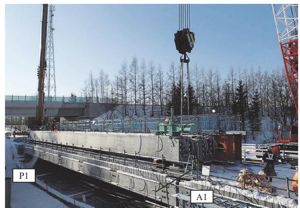
写真-6 主桁架設状況その2
