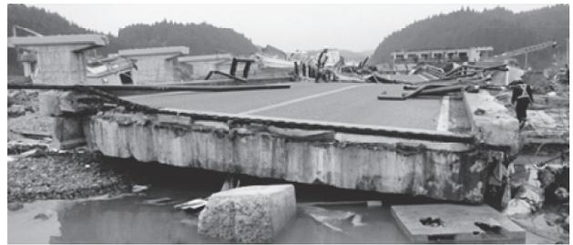
写真 - 4 コンクリート上部構造が裏返らずに流出
