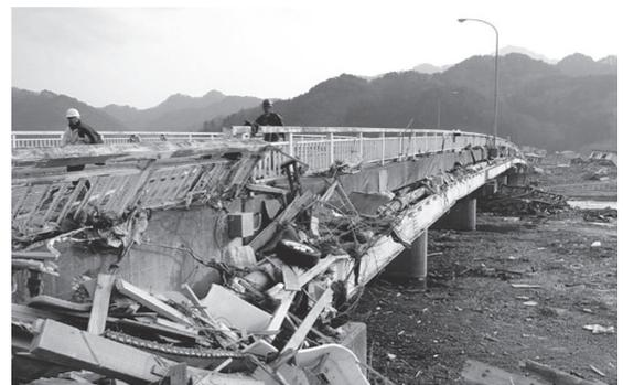
写真 - 6 津波が桁の高さまで達したが流出していない橋
