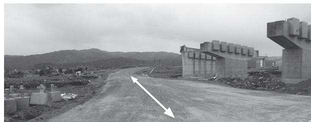
写真 - 8 線路上への仮設盛土の設置による応急復旧
