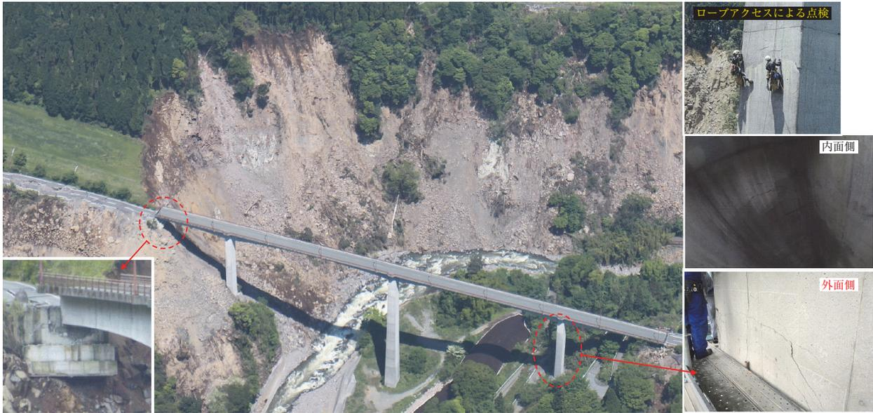
写真 - 13 阿蘇長陽大橋と熊本地震による主な被災状況
