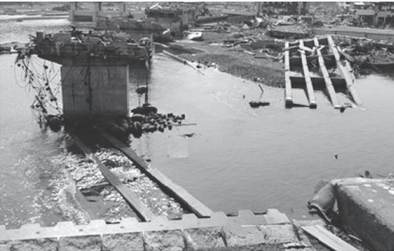
写真 - 3 コンクリート上部構造が裏返しになって流出
