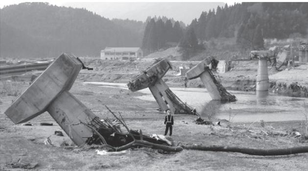
写真 - 5 下部構造の損壊を伴って上部構造が流出
