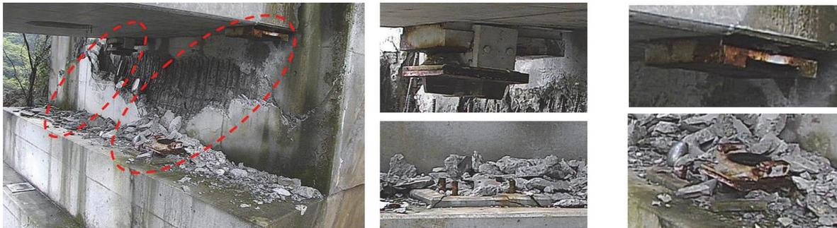
写真 - 14 張出し架設工法により施工されたPC ラーメン橋の構造リダンダンシーの発揮に役割を資した支承の破壊
