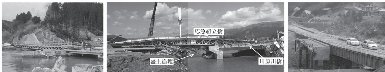
写真 - 9 応急組立橋の設置による応急復旧 (写真 7～9 提供: 国土交通省東北地方整備局)
