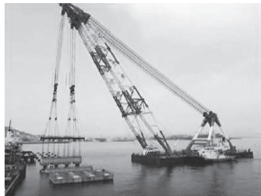
写真-9 プレキャスト受梁の架設 (国土交通省北海道開発局函館開発建設部提供)
