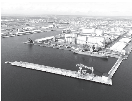
写真 - 2 国際物流ターミナル (国土交通省北海道開発局釧路開発建設部提供)
