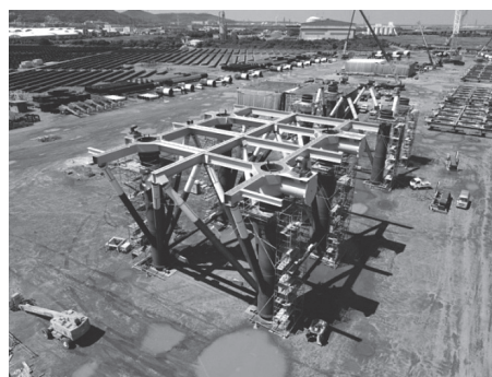
写真 - 3 ジャケット製作状況 (国土交通省北海道開発局釧路開発建設部 HP より)
