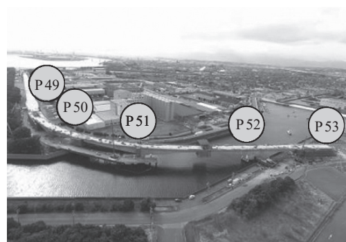
写真 - 12 後ラーメン工が採用されたPCラーメン箱桁橋 (国土交通省中部地方整備局四日市港湾事務所提供)
