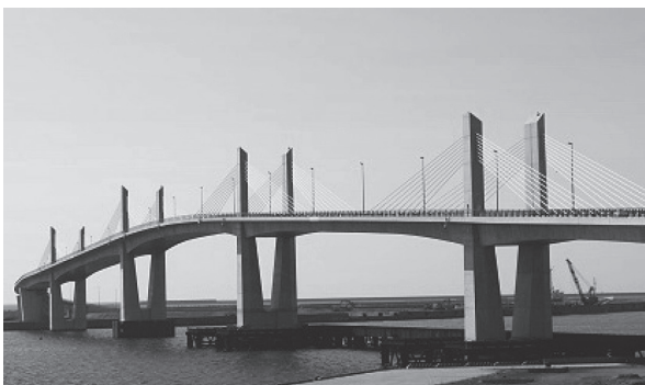
写真 - 5 小名浜マリナブリッジ (国土交通省東北地方整備局小名浜港湾事務所 HP より)
