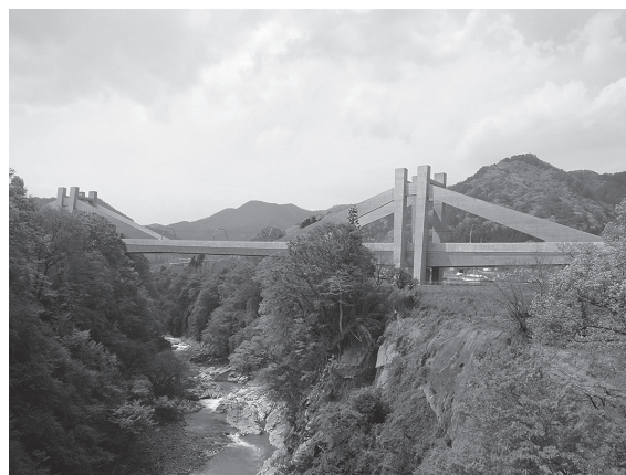
写真-1 吾妻線第二吾妻川橋梁
