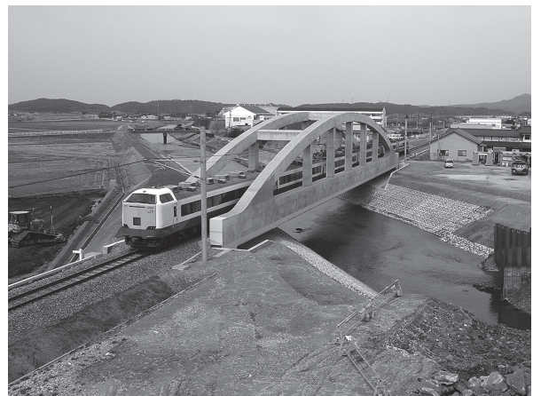
写真 - 4 羽越本線三跨川橋梁
