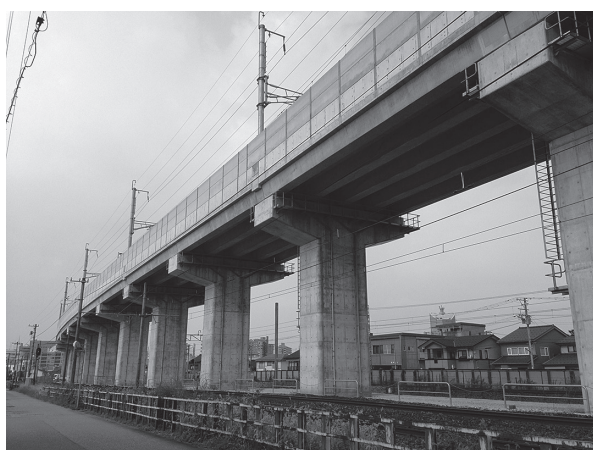
写真 - 6 北陸新幹線富山駅付近
