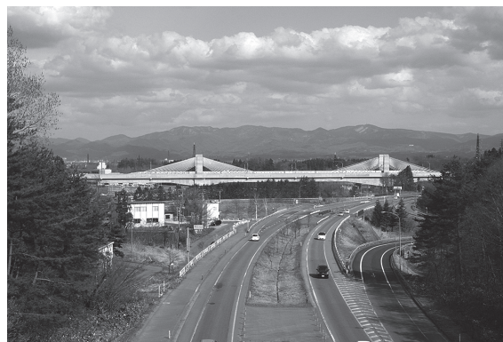
写真-2 東北新幹線三内丸山架道橋
