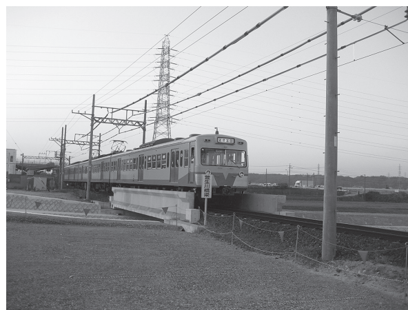
写真 - 7 三岐鉄道萱生川橋梁
