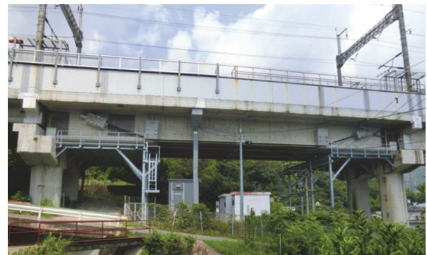
写真 - 11 実構造物での試験施工状況
