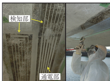
写真 - 10 桁下面への導電塗料塗布
