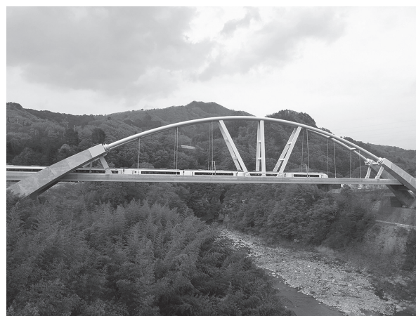
写真 - 8 吾妻線第三吾妻川橋梁
