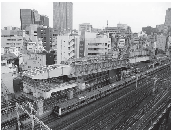
写真 - 5 東北縦貫線の施工
