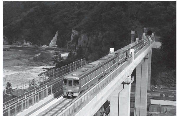
写真 - 3 山陰本線余部橋梁
