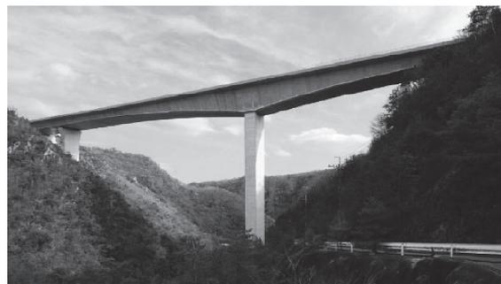
写真 - 8 川下川橋の高強度 RC 橋脚
