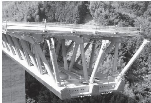
写真 - 2 PC複合トラス橋(3主構トラス)の張出し架設
