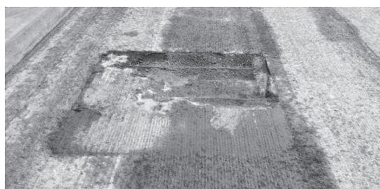
写真 - 14 床版上面コンクリートの劣化事例
