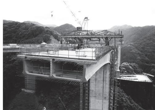
写真 - 4 錐ヶ瀧橋のプレテンションウェブ箱桁橋
