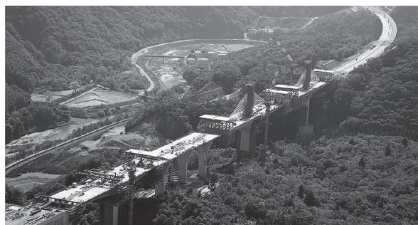
写真 - 9 生野大橋の片持ち張出し架設状況
