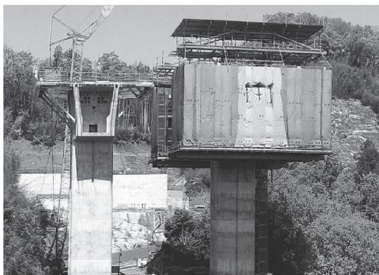
写真 - 6 郡界川橋の片持ち張出し施工
