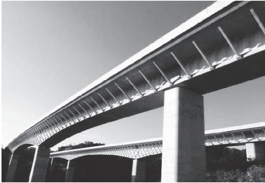
写真 - 1 谷津川橋のストラットと波形鋼板ウェブ
