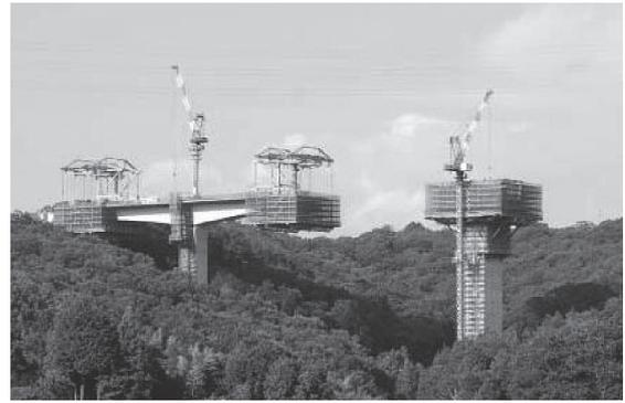
写真 - 3 青木川橋の上部工張出し架設状況
