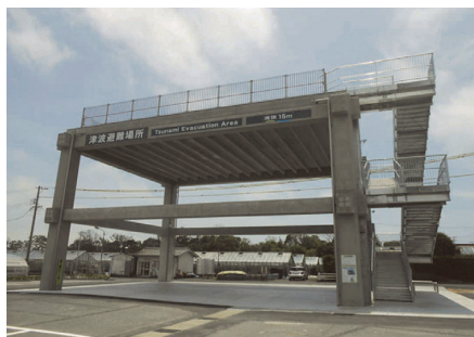
写真-1 津波避難施設の例（菊浜地区津波避難タワー 6) ）
