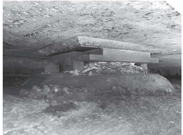
写真 - 1 既設支承の状況
