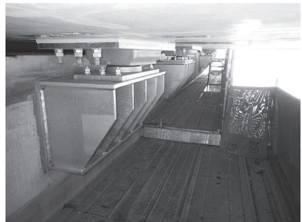
写真-2 鋼製ストッパー設置状況
