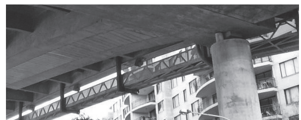
写真 - 15 張出し床版裏側に設置された検査路
