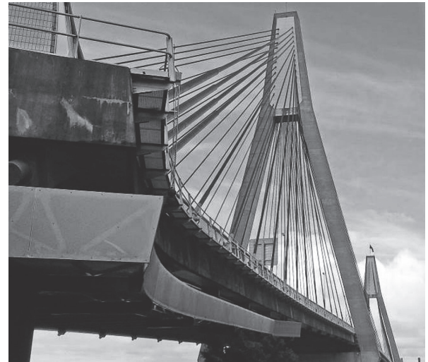
写真 - 14 Anzac 高架橋
