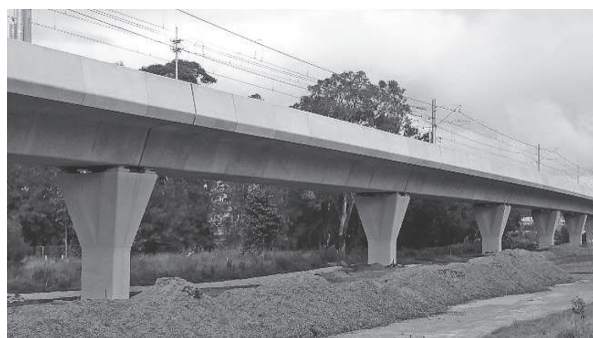
写真 - 21 Metro Railway 橋
