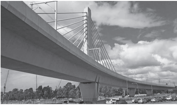
写真 - 22 Windsor Road 橋
