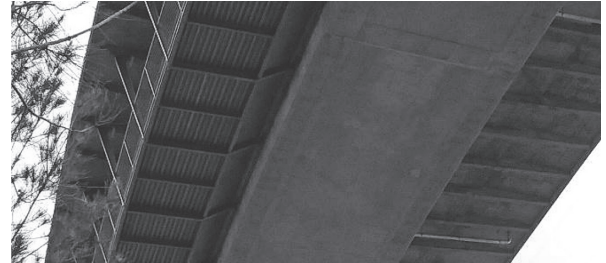
写真 - 25 張出し床版裏側の歩道
