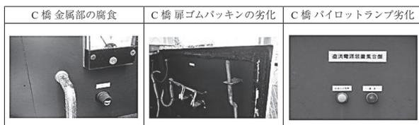
図 - 7 実橋調査で確認された直流電源装置の主な変状
