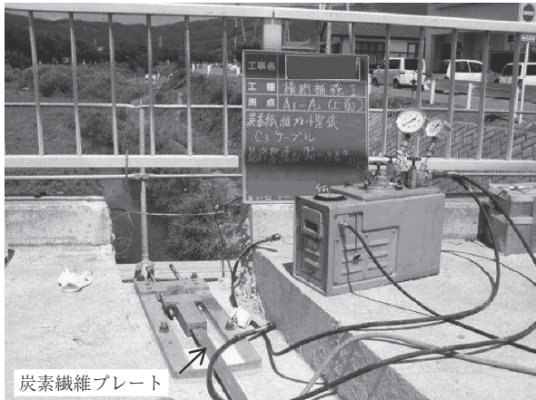
写真 - 8 横桁上面の炭素繊維プレート緊張材配置
