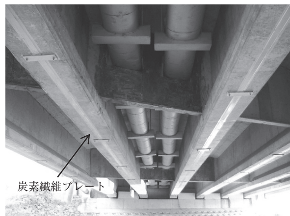
写真 - 7 炭素繊維プレート緊張材による主鋼材の補強
