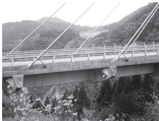
写真 - 7 斜材ケーブルの定着部と横桁
