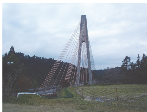
写真 - 6 淡い光に映える鮎の瀬大橋
