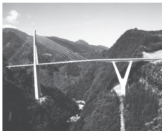
写真-1 上流側からの鮎の瀬大橋の全景 （三井住友建設（株）よりご提供）
