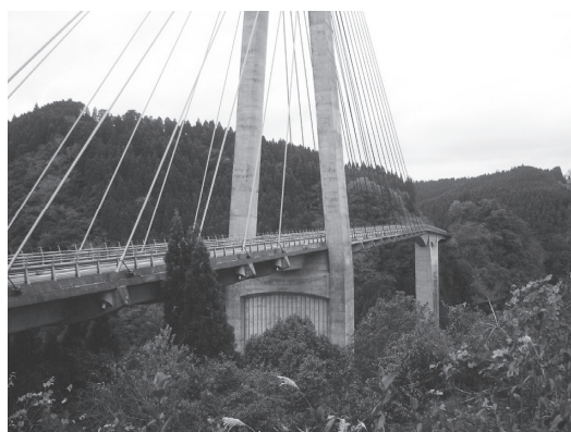
写真 - 8 鮎の瀬大橋の主桁
