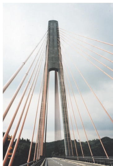
写真 - 3 鮎の瀬大橋の斜材
