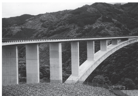
写真 - 12 天翔大橋のアーチリブと鉛直壁
