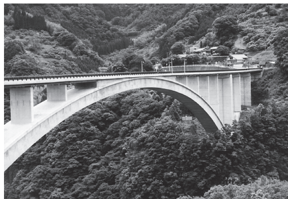
写真 - 11 天翔大橋
