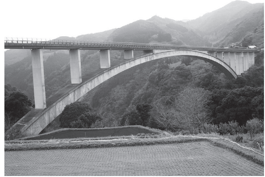
写真 - 15 左岸上流側からの天翔大橋
