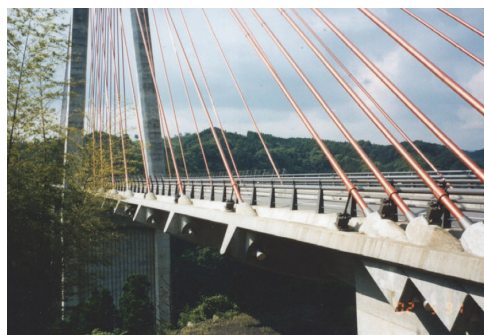
写真 - 4 橋脚の縦縞のスリット、定着部と横桁の形状寸法
