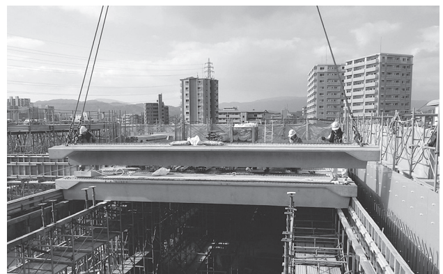
写真 - 5 ハーフ PCa 床版架設状況
