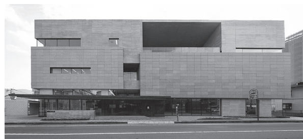
写真 - 1 建物外観（北西面）
