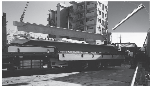
写真 - 4 ハーフ PCa 床版搬入・吊上げ状況
