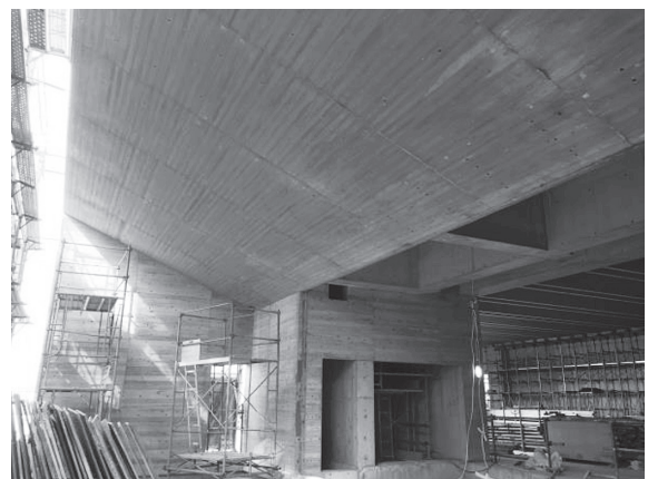
写真 - 2 底部分施工状況
