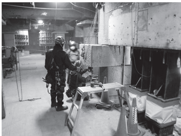
写真 - 4 切断塊の引き抜き
