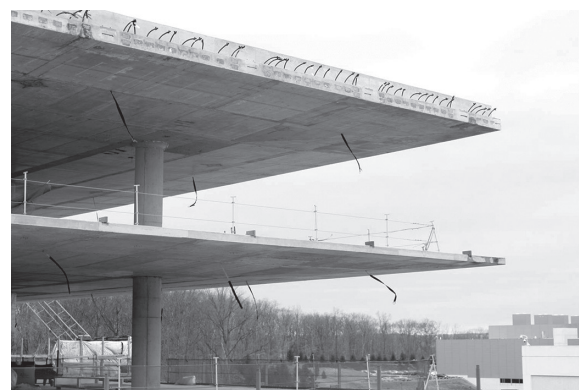
図-5 12 mの跳ね出しスラブの角部
