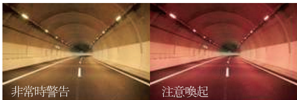
写真-7 アクシデント発生時の点滅状況
