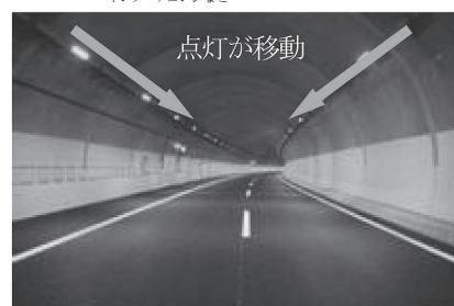
図 - 6 サグ部での走行支援時の点灯状況
