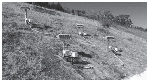
(a) 切土法面の計器設置状況
