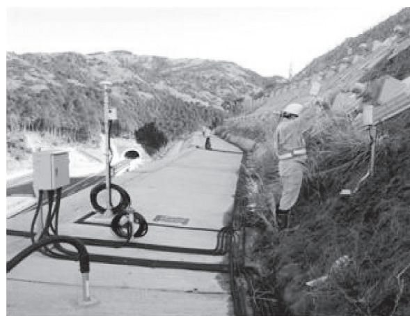
写真 - 4 従来システムによるアンカー荷重計測現場
