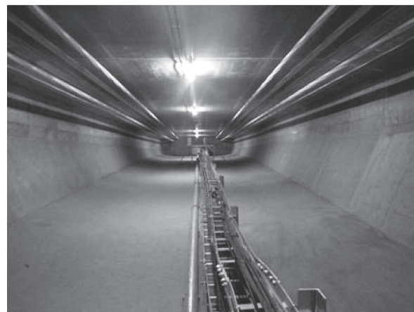
写真 - 3 照明設置状況
