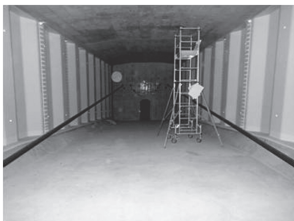
写真 - 2 移動式点検足場配置状況
