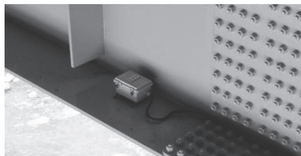
(c) 主桁の加速度計測状況
