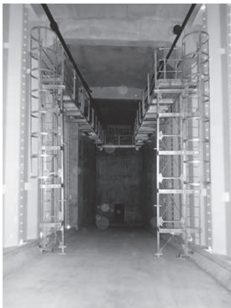
写真 - 1 支点部付近の検査路設置状況
