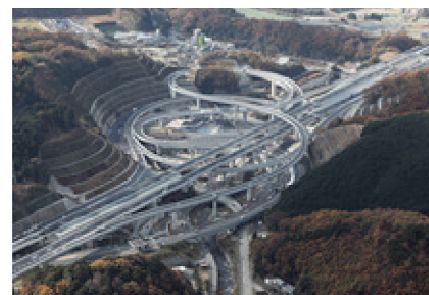
写真 - 10 箕面とどろみ IC 全景
