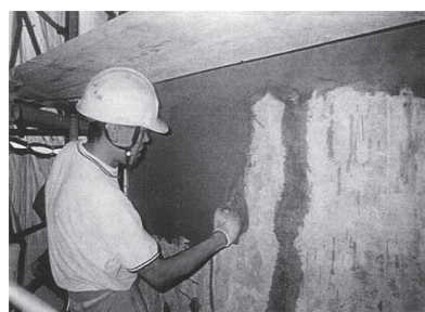
写真 - 1 表面被覆工法の施工状況
