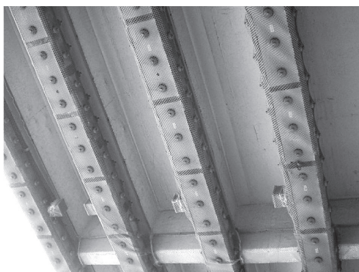
写真 - 2 外部配置式の流電陽極の施工例
