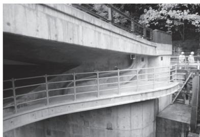
写真-7 橋梁端部の曲面形状
