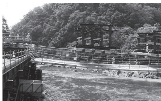
写真 - 2 PCa吊床版ユニットの引き出し架設
