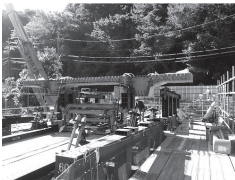
写真 - 4 PCa 上床版の引出し架設
