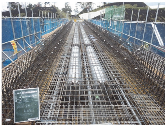
写真 - 7 配筋状況
