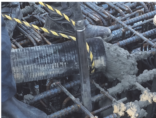
写真 - 8 コンクリートの打込み状況
