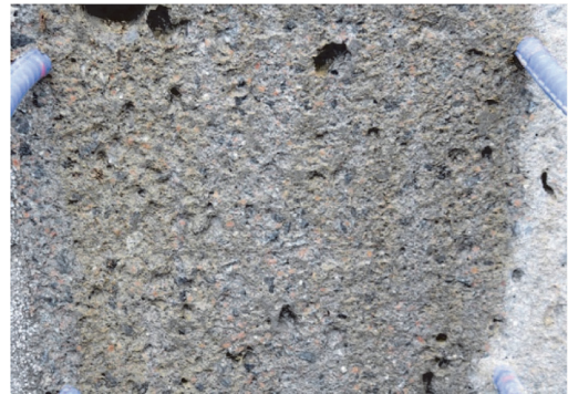
写真 - 10 桁端部の踏掛版受台打継目粗し面の近景
