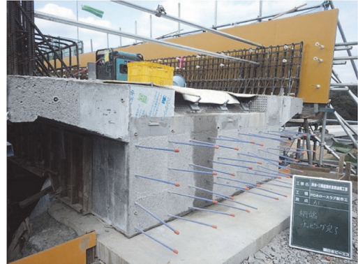
写真 - 9 桁端部全景
