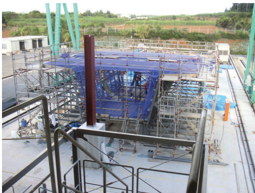
写真 - 1 鉄筋のプレファブ化の例（伊良部大橋のプレキャストセグメント製作）
