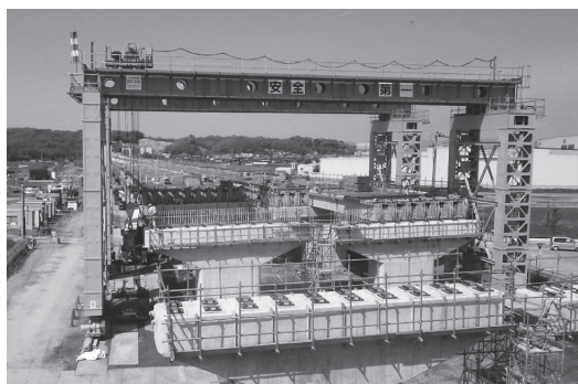
写真-6 架設状況
