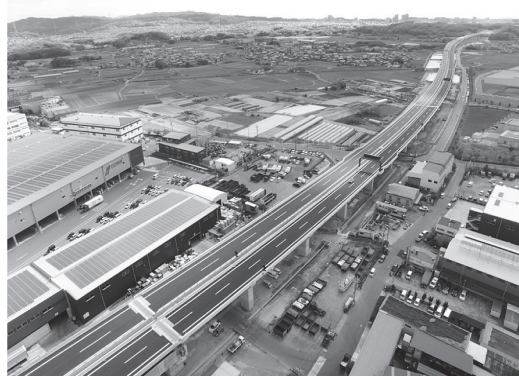
写真-8 完成写真(上:A2より, 下:P12より)
