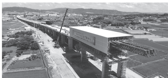
写真 - 2 移動支保工全景
