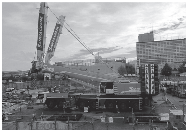
写真 - 2 450tオールテレーンクレーン
