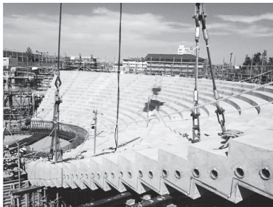
PCa 部材の架設（古墳 A）
