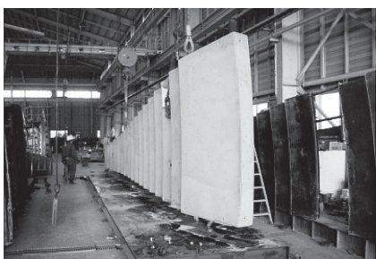
側枠取外し状況
