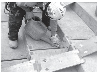
目地モルタルの打込み
