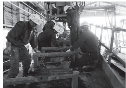
コンクリート打込み状況
