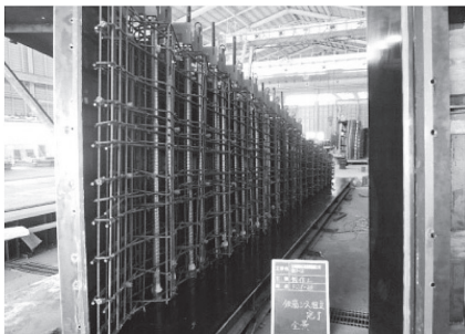
鉄筋・シース配置完了
