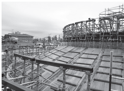
支保工の設置状況
