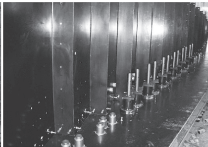
底版・側枠組立て
