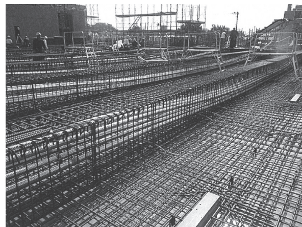
写真 - 4 PC 鋼材配線状況
