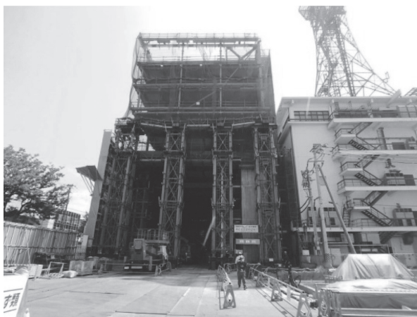
写真 - 2 ベント設置後 鉄骨建て方（北面）
