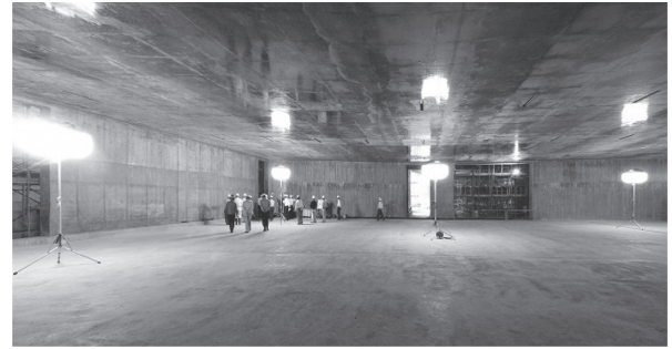
写真 - 6 支保工解体後の状況
