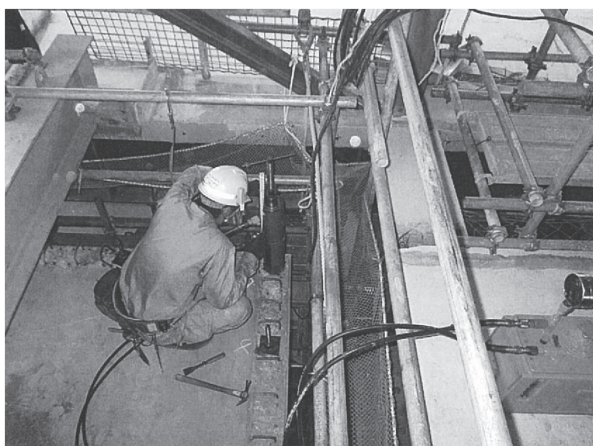
写真 - 8 PC 鋼材緊張状況
