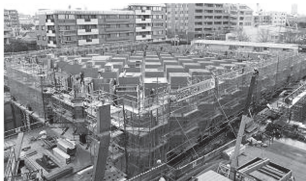
写真 - 6 PC 梁型枠状況
