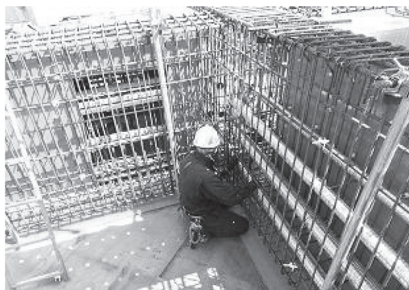
写真 - 7 シース施工状況
