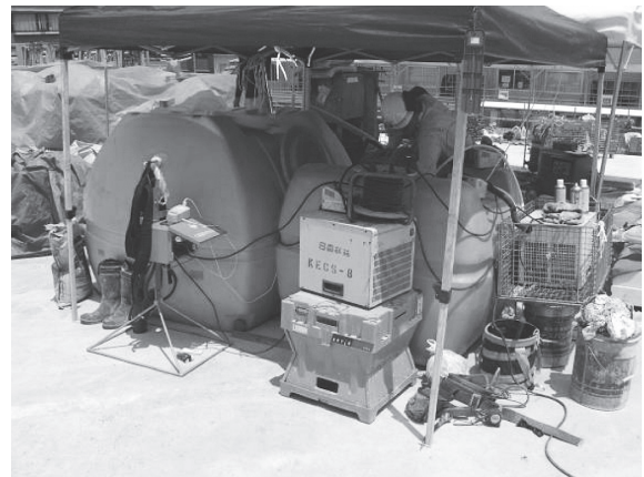
写真-9 グラウト練場施工状況
