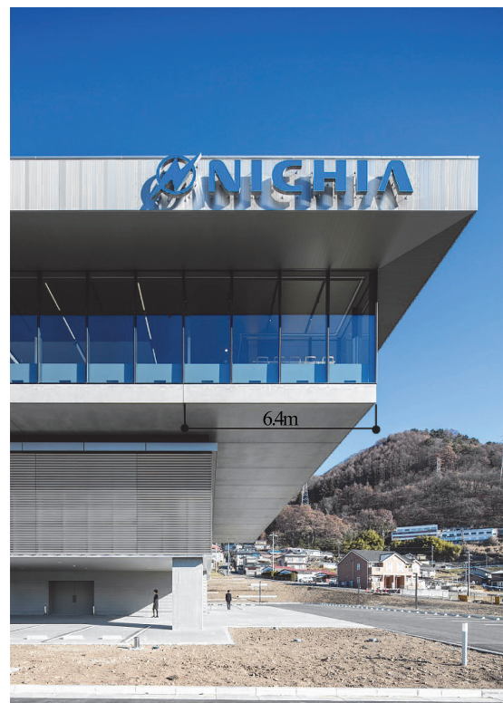
写真-5 6.4m跳出し見上げ
