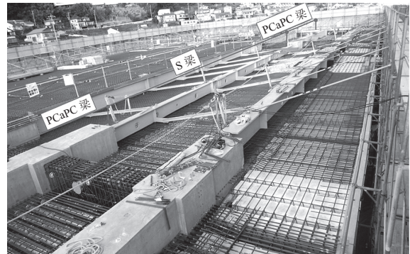
写真 - 3 PCaPC 梁と S 梁 全景
