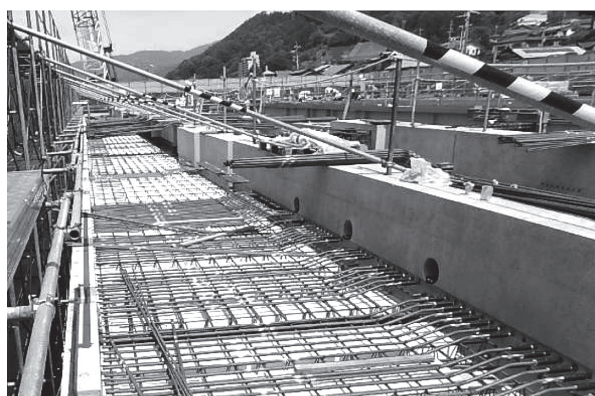
写真 - 15 PCaPC 梁側面の定着筋
