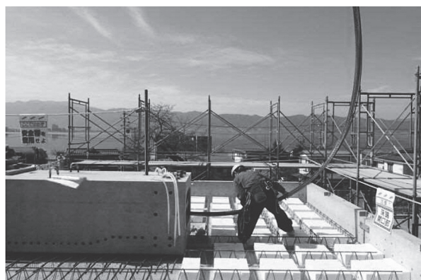
写真 - 14 PC 鋼線挿入状況
