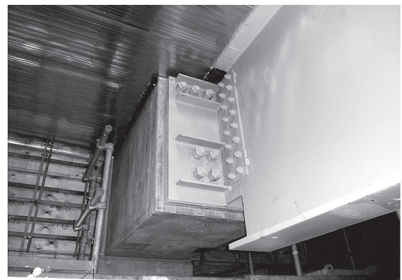
写真 - 4 PCaPC 梁と S 梁の接合部
