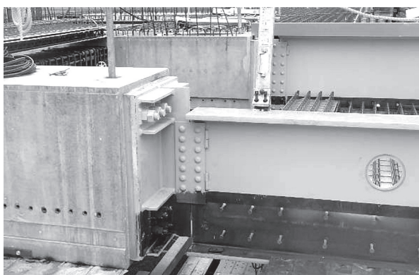
写真 - 12 PCaPC 梁と鉄骨部材の取合い
