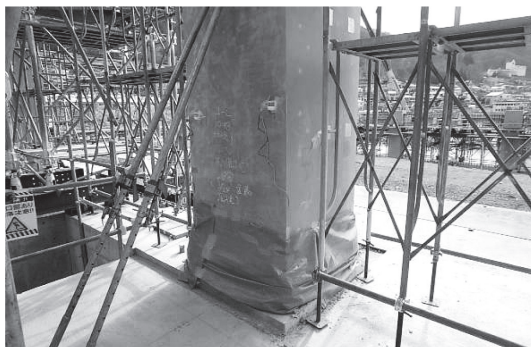
写真 - 10 PCa 柱脚部採暖養生
