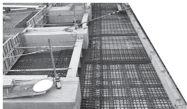
写真-6 6.4m跳出し部配筋状況
