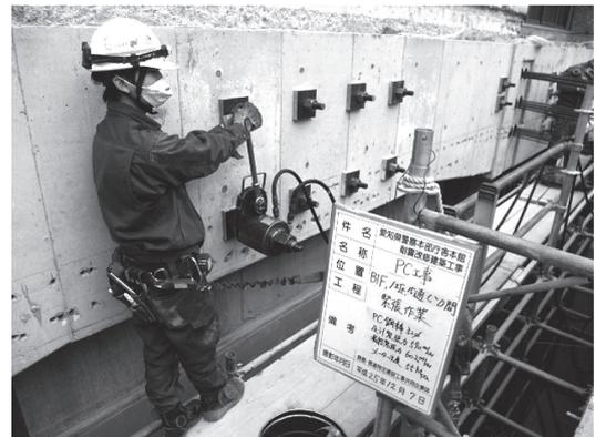
写真-5 PC鋼棒緊張状況
