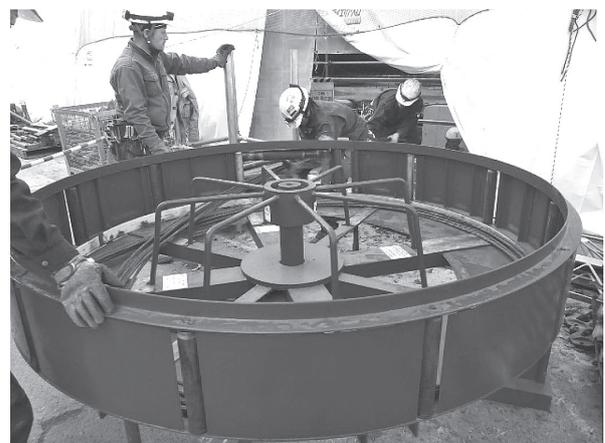
写真 - 2 ターンテーブルセット状況
