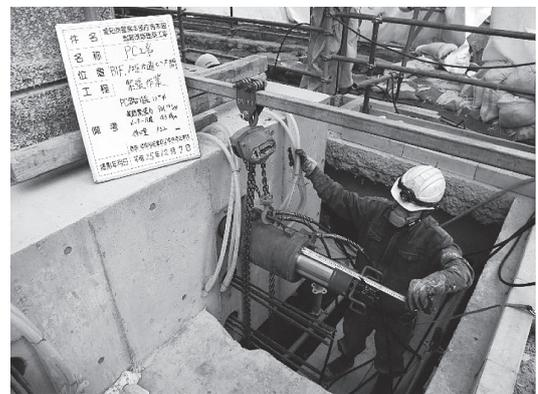
写真-6 PCより線緊張状況
