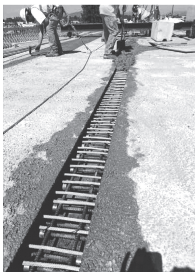
写真-3 接合部打設状況
