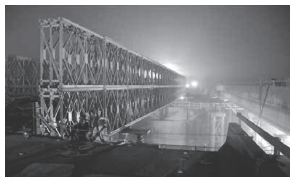
写真 - 7 横取り架設状況
