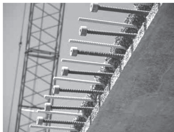
写真 - 6 ヘッド付きスタッド鉄筋の配置状況
