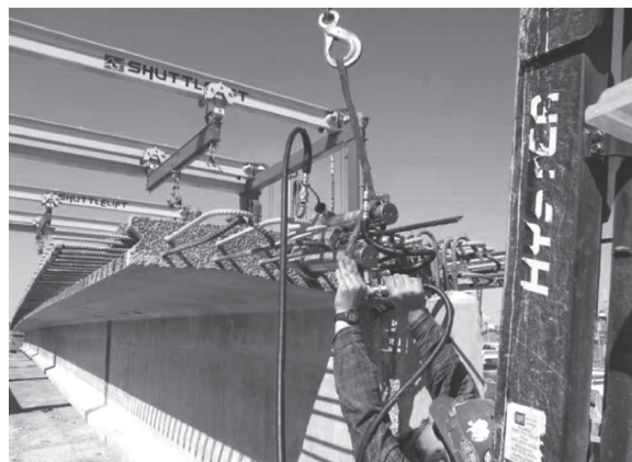
写真 - 5 仮設 PC 鋼材の緊張状況
