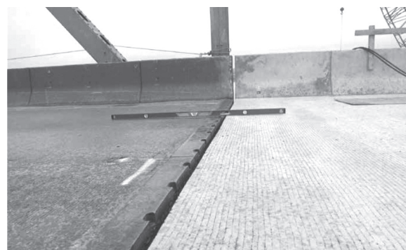
写真 - 8 架設後の遊間部
