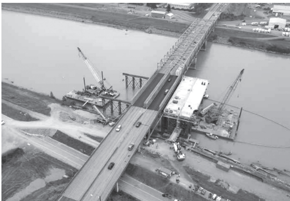
写真 - 2 本設橋と仮設橋（本設橋が仮設橋の横に建設された）
