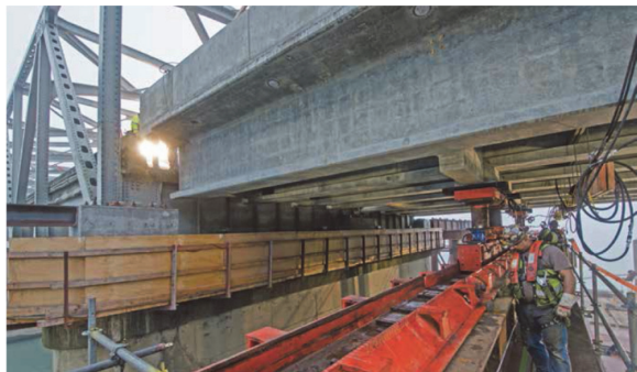
写真 - 4 本設橋設置状況
