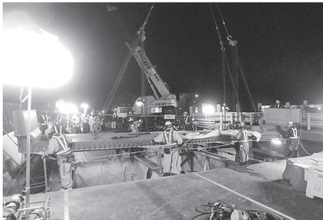
写真 - 5 PCa 架設状況 (200 tf クレーン)
