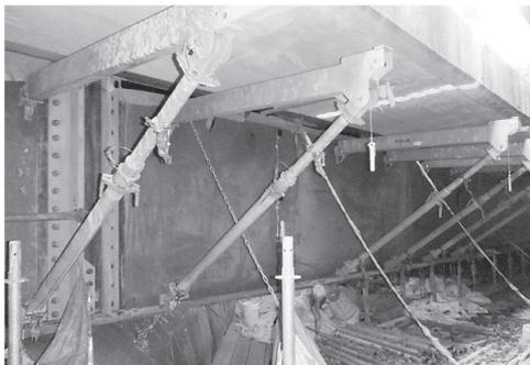
写真-1 仮設サポート設置状況
