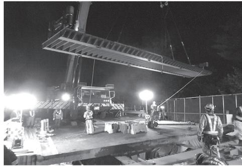
写真 - 7 仮設鋼床版設置状況
