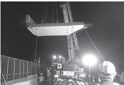
写真 - 6 PCa 架設状況 (50 tf クレーン)
