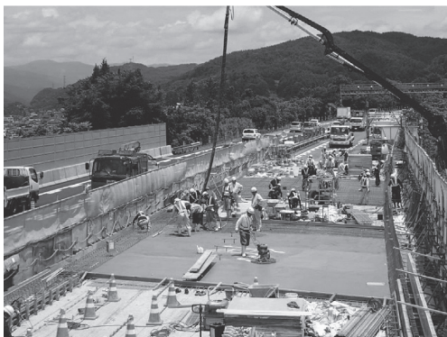
写真 - 9 床版コンクリート打設状況
