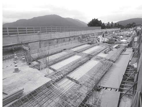
写真 - 8 床版撤去完了
