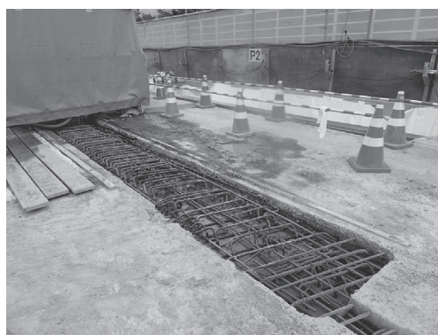
写真 - 5 主桁上はつり状況
