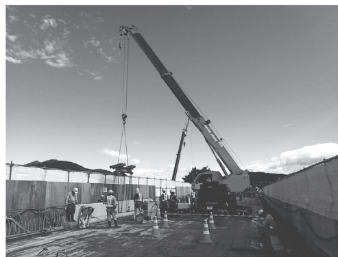
写真 - 7 ブロック撤去状況
