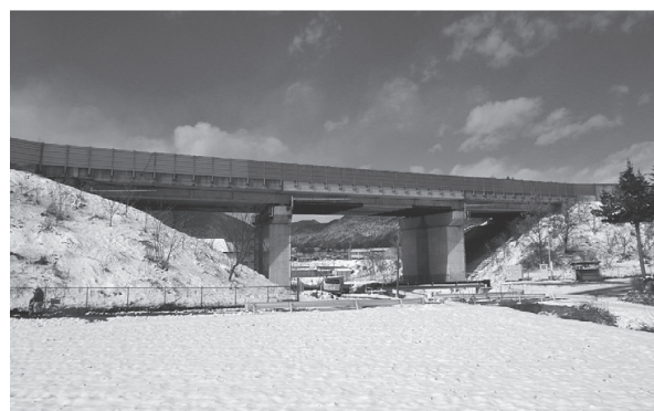
写真 - 1 沢底川橋（着工前）
