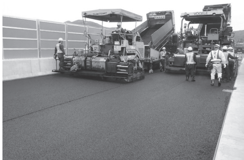
写真 - 10 舗装の施工状況
