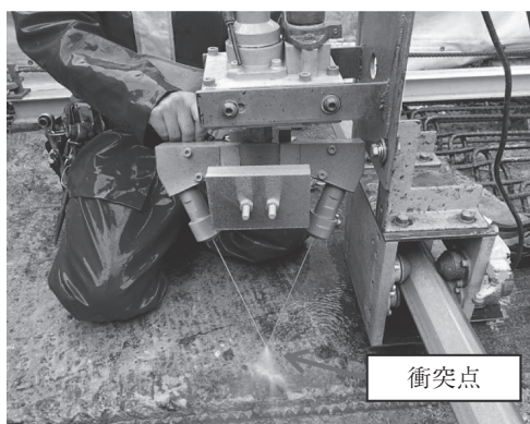
写真 - 4 コリジョンジェットノズル
