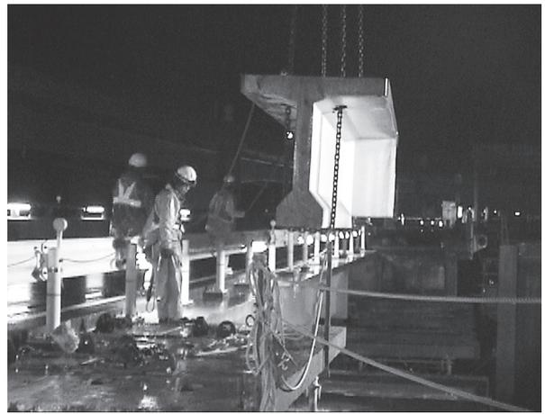
写真 - 15 主桁撤去
