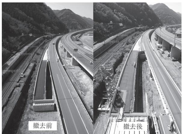
写真 - 16 主桁撤去前後の状況（始点側より）
