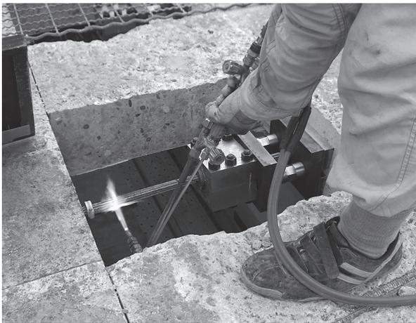
写真 - 13 PC 鋼材切断
