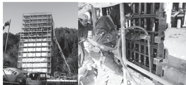
写真-1 CF工法による橋脚の施工状況
