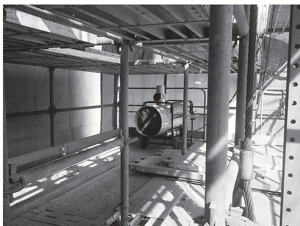
写真 - 4 ジェットヒーター 給熱養生状況
