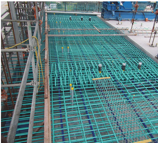
写真 - 6 エポキシ樹脂塗装鉄筋組立完了
