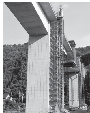
写真-2 CF工法による橋脚の全景
