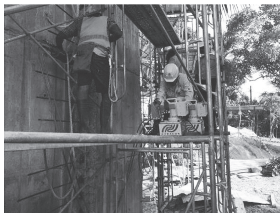
写真 - 15 水平方向 PC スtrandの緊張状況
