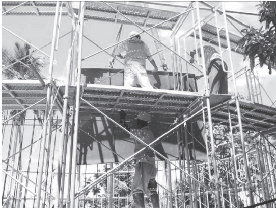
写真 - 9 型枠の設置（鋼製型枠）
