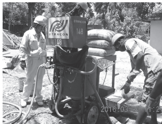
写真 - 16 グラウトミキサーとポンプ
