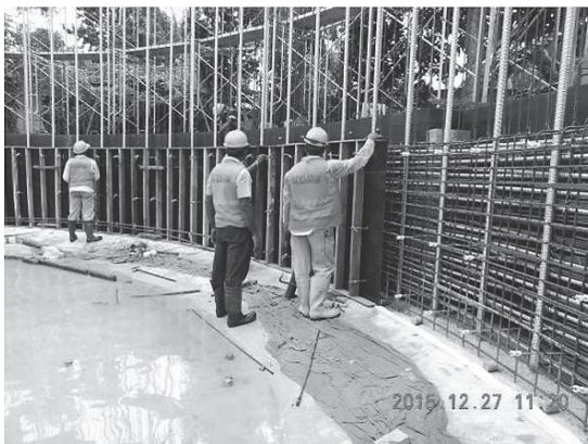
写真 - 10 型枠の設置（合板型枠）
