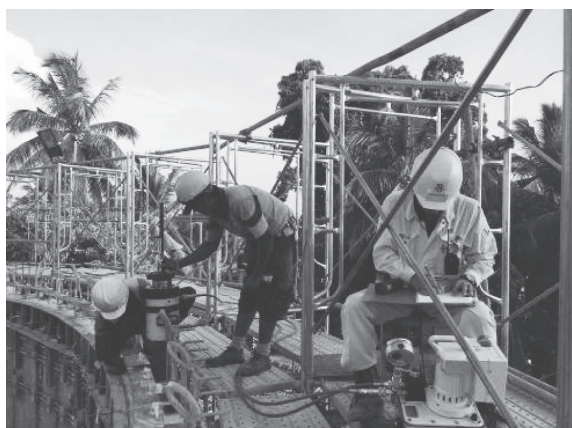
写真 - 14 鉛直方向 PC 鋼棒の緊張状況
