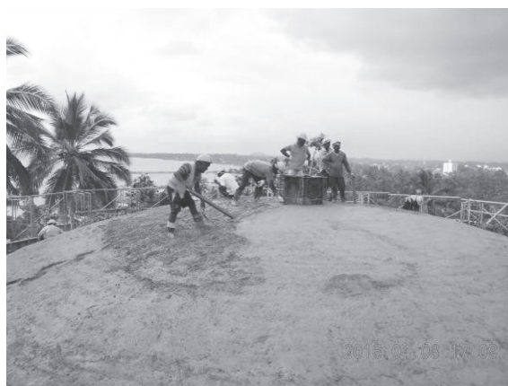
写真 - 20 屋根コンクリートの打設状況
