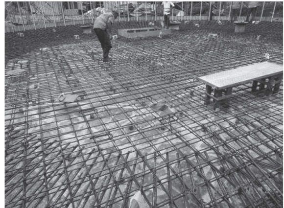
写真 - 2 鉄筋の組立て状況
