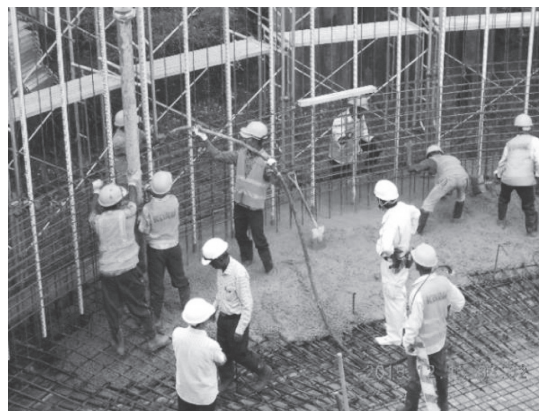
写真 - 7 底版コンクリート打設状況
