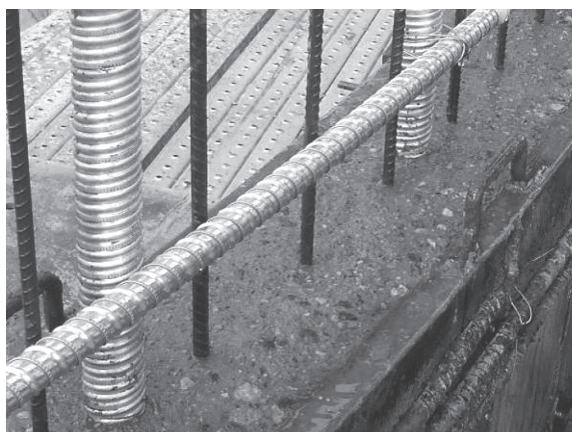
写真 - 13 遅延剤と高圧洗浄水による打継目処理
