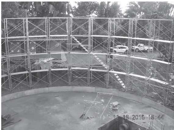
写真 - 1 外足場組立て状況
