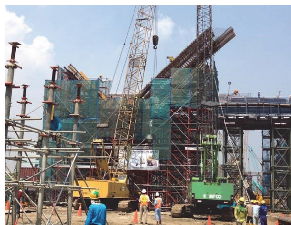
写真-2 鉄筋籠吊込み状況写真
