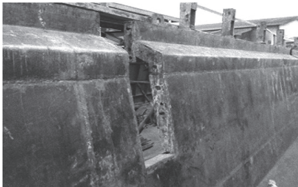
写真 - 4 外型枠の横桁用開口
