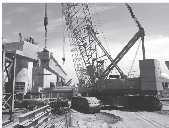
写真 - 7 クレーンでの桁架設状況写真
