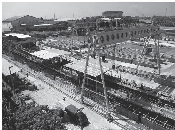
写真-3 PC-U桁製作ヤードの状況写真
