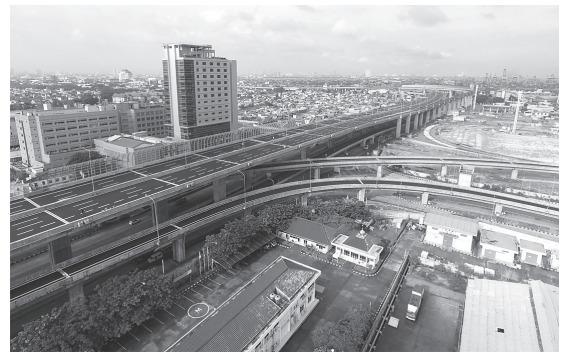
写真 - 1 完成航空写真
