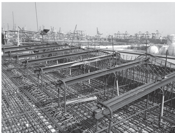
写真 - 10 床版型枠構造
