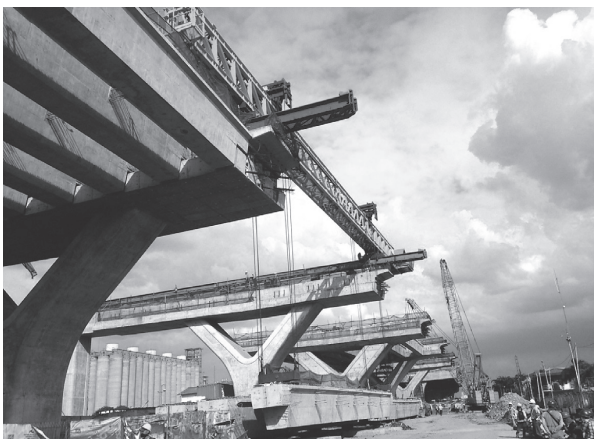
写真 - 6 ビームリフターでの桁架設状況写真
