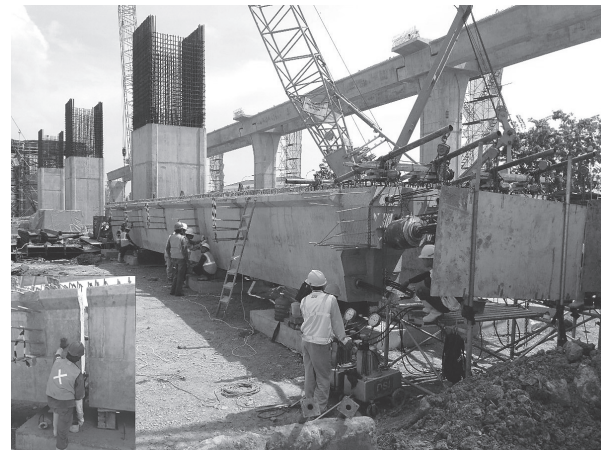
写真 - 5 一体化の仮置状況写真
