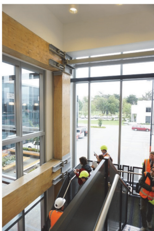
写真 - 3 木造プレストレス (Pres-Lam) 建物
