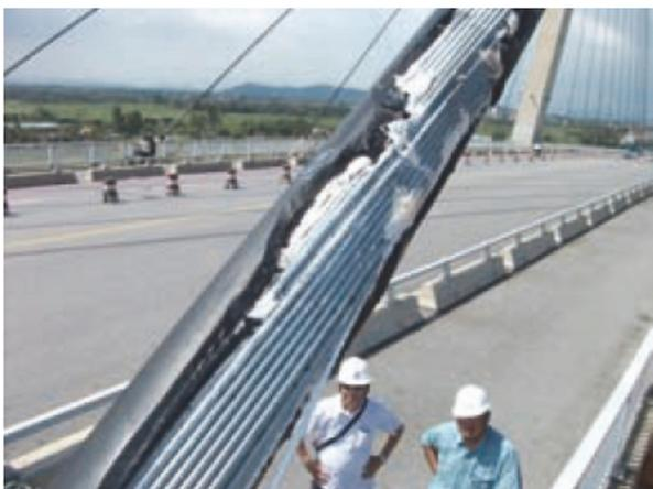
写真 - 12 損傷した Binh 橋の斜ケーブル 17)
