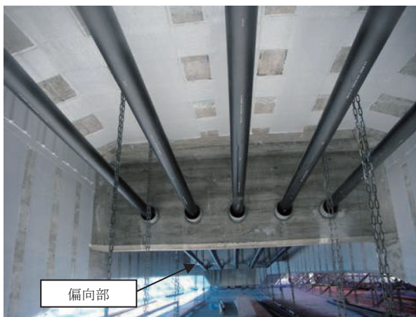
写真 - 1 外ケーブル配置状況
