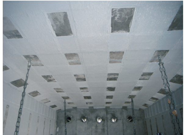
写真 - 2 床版下面補強
