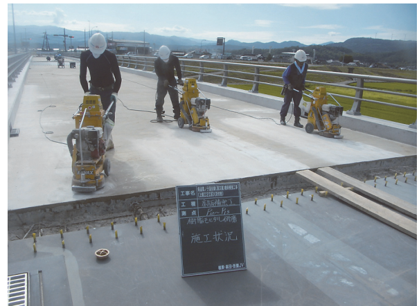
写真 - 5 樹脂モルタル表面研磨状況
