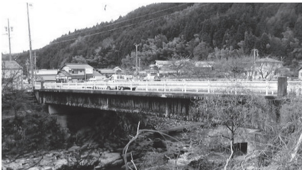
写真 - 1 調査対象橋梁全景
