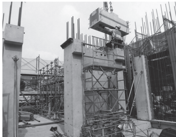
写真 - 2 壁柱部材とレンコン梁
