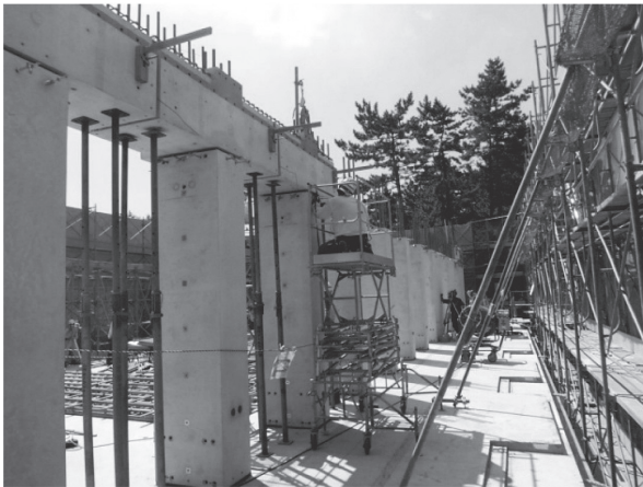
写真 - 4 架設精度の確認状況
