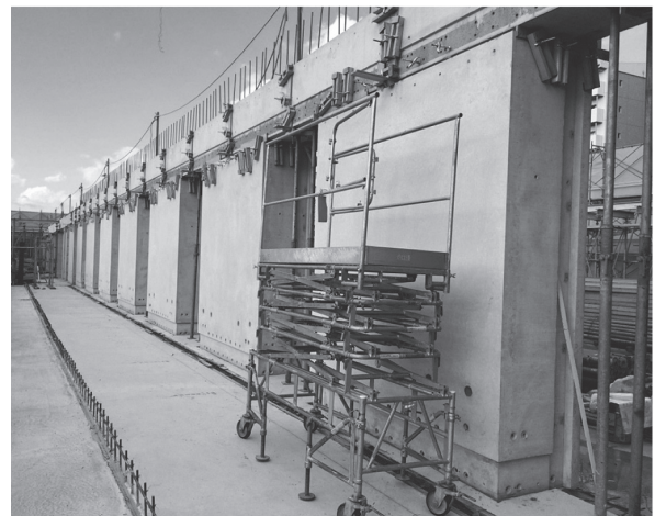
写真 - 7 PC 壁柱建方状況
