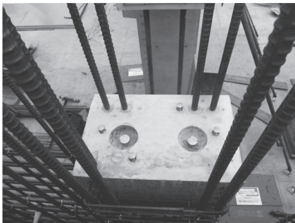
写真 - 5 柱頭部天丸ボルト
