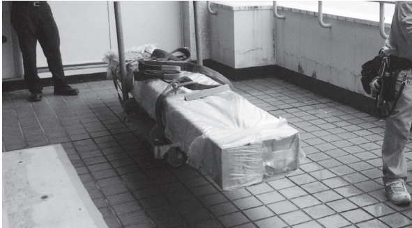
写真 - 3 ブレース材 搬入状況
