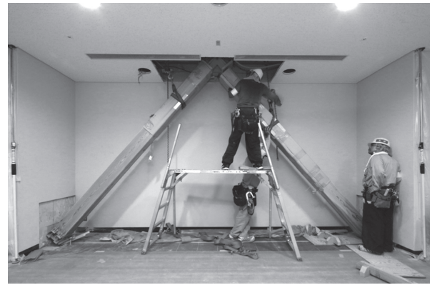
(c) ブレース取付け状況 ③ 位置調整
