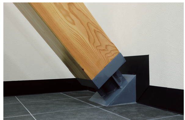
写真 - 13 ブレース下端接合部
