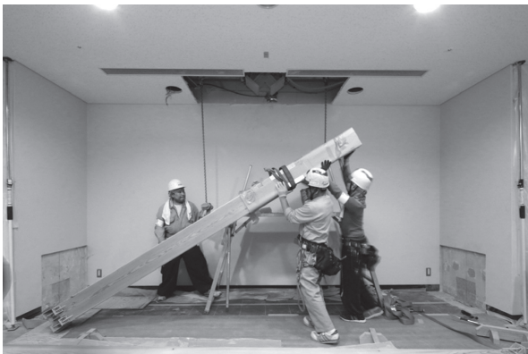
(a) ブレース取付け状況 ① 1 本目建起し
