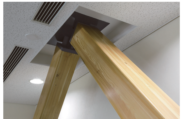
写真 - 12 ブレース上端接合部
