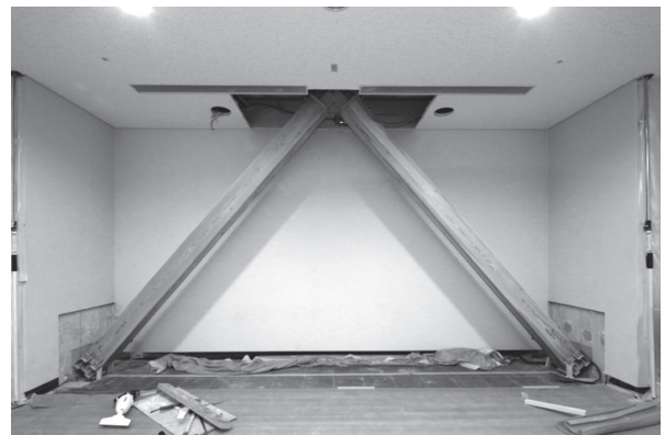
(d) ブレース取付け状況 ④ 据付け完了
