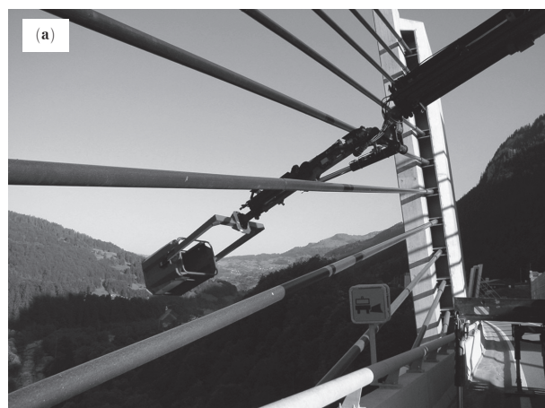
図 - 13 昇降つりかごによる床版へのアクセス
