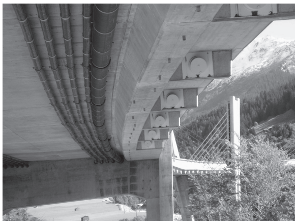
図 - 15 床版下面の電線管・排水管・斜材定着
