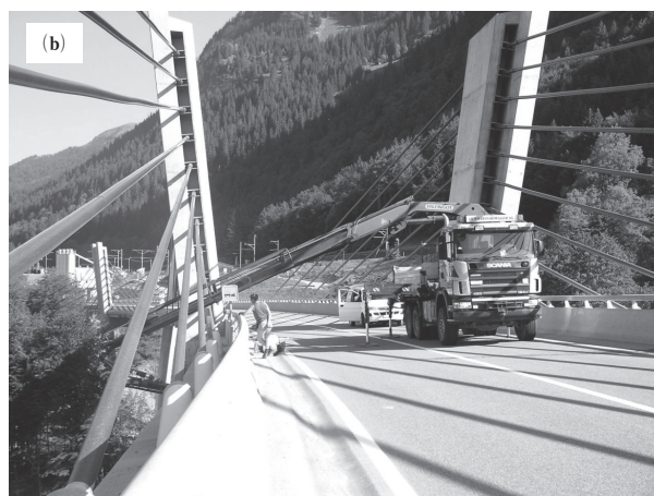
図 - 13 昇降つりかごによる床版へのアクセス
