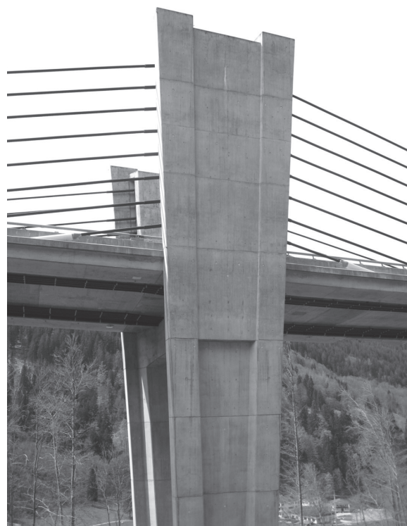
図 - 8 ズンニベルグ橋のパイロン
