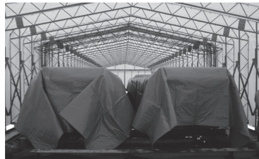
写真-5 保温養生状況
