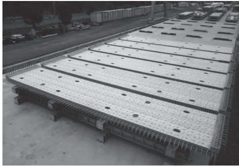
写真 - 6 平坦性確認試験
