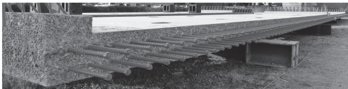
写真 - 1 合理化継手を使用したプレキャスト PC 床版
