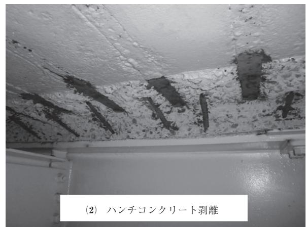
写真 - 3 床版下面の劣化状況
