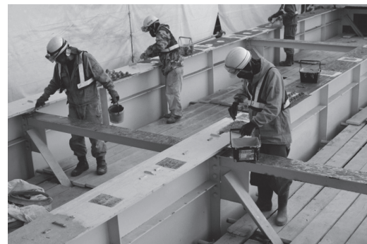
写真 - 8 防錆材塗布状況
