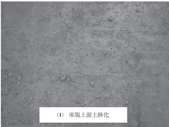
写真 - 2 床版上面の劣化状況
