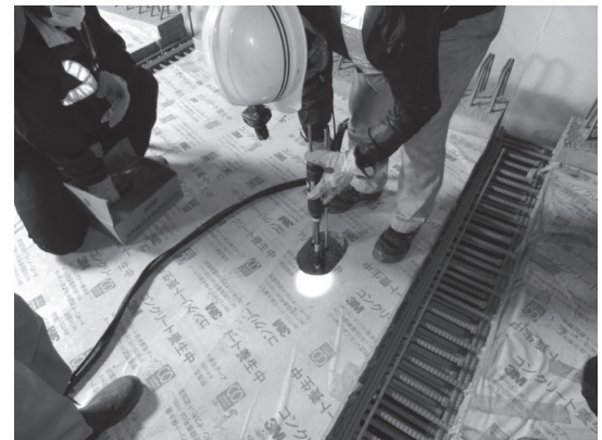
写真 - 12 スタッドジベル溶植状況
