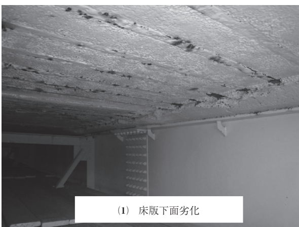
写真 - 3 床版下面の劣化状況
