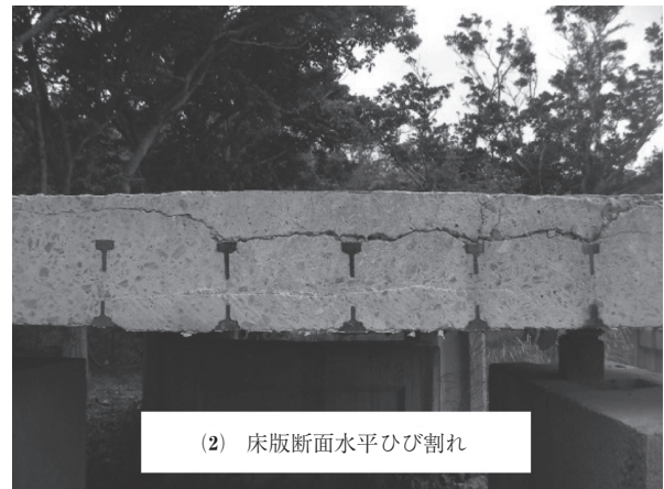
写真 - 2 床版上面の劣化状況
