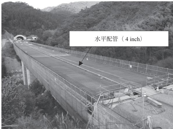
写真 - 4 水平配管によるポンプ打設
