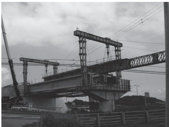
写真 - 5 一般的な上路式の架設桁移動
