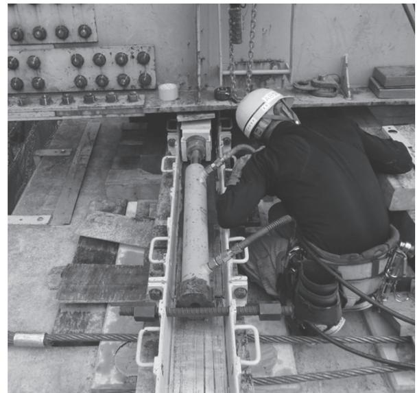
写真 - 7 横取り装置による角度調整状況
