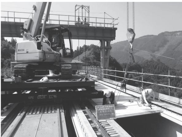
写真-2 G1～G2桁間のPC板先行設置
