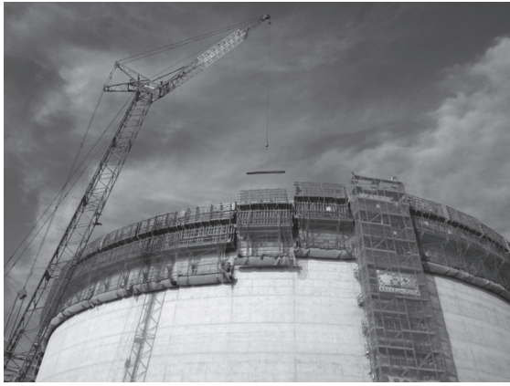
型枠の揚げ降ろし不要（風の制約を受けにくい）
