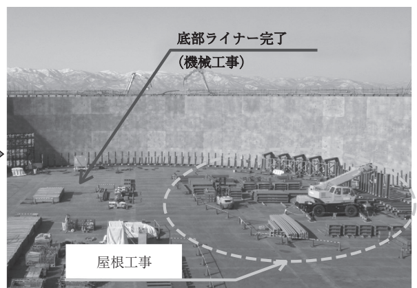
(b) 新工法 (機械工事は施工中)
