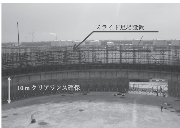
(a) 従来工法 (機械工事の着手可能)
