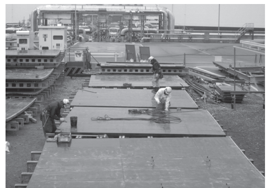
写真 - 4 型枠仮置き状況（従来工法）
