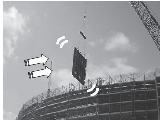
型枠の揚げ降ろしが必要（強風時、大風状態）
