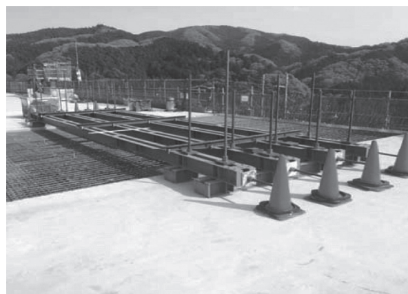
写真 - 3 緊結工設置状況
