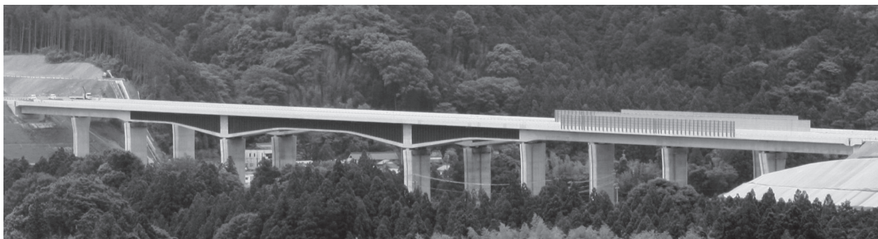
写真 - 5 完成写真 (全景)
