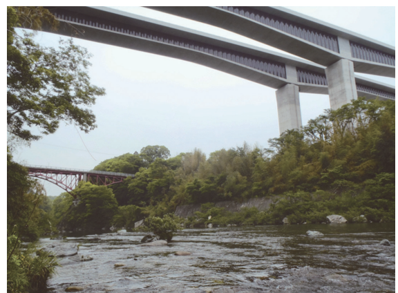
写真 - 2 完成した波形鋼板ウェブ
