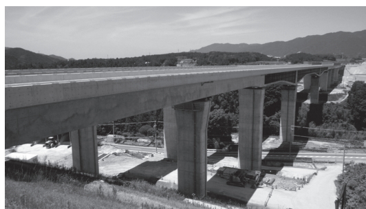
写真 - 1 完成写真
