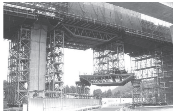
写真 - 4 支保工設置状況
